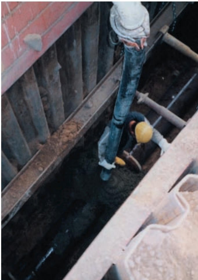
Einbringen der aus RSS-Flüssigboden steiferer Konsistenz Belastungsbänke.
