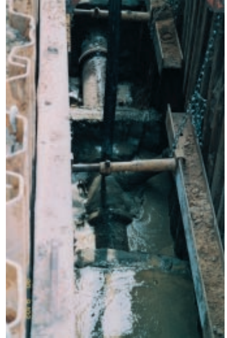
Einbringen des Flüssigbodens mit Betonpumpe.
