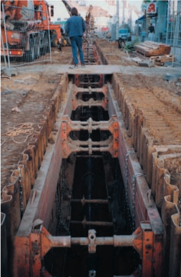
Rohrgraben vor der Verfüllung.
