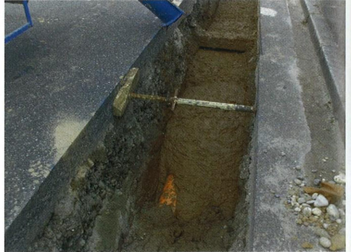
... und mit Flüssigboden verfüllen.
