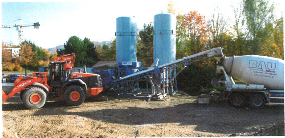
Eine der beiden Flüssigboden-Kompaktanlagen der BAU GmbH im Einsatz.
