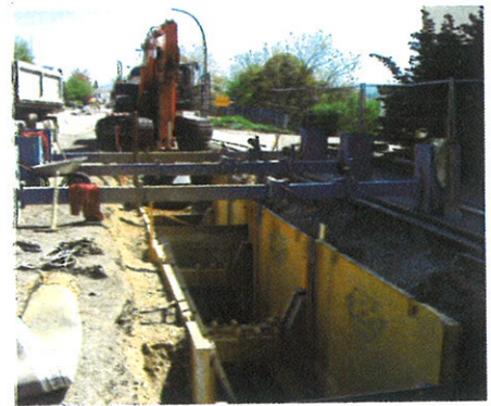
Offener Kanalbau: Eine der Kernkompetenzen der BAU GmbH aus Wehr.
