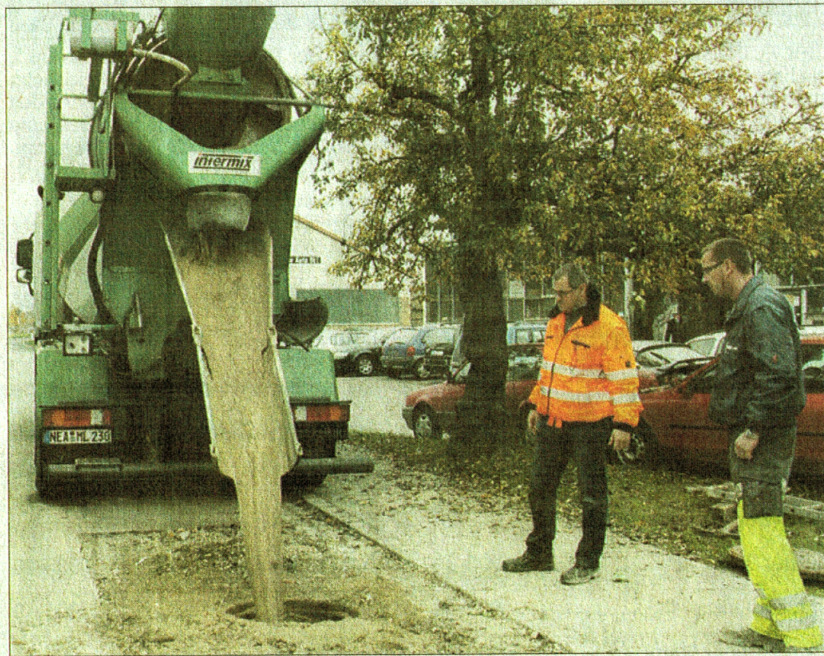
Norbert Strauß (links) und Sven Sauer überprüfen das Auffüllen der Keller in Lenkersheim mit Flüssigboden. Foto: Simone Schinnerer
