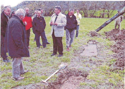
Die Flüssigboden-Technologie bestand bei der Vorführung vor rund 50 Baufachleuten den Praxistest.
