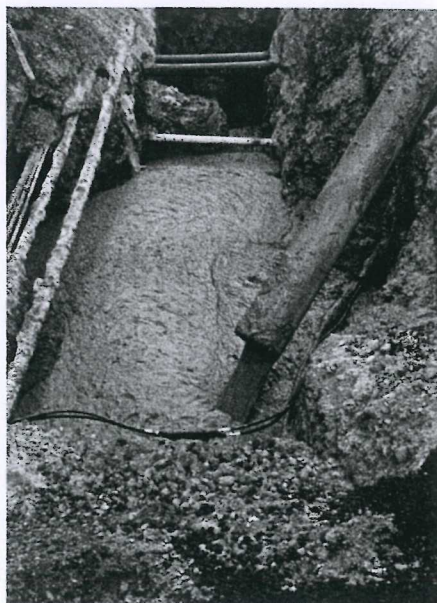
Abb. 7: Geringe Fallhöhen während des Einfüllens verhindern das Entmischen von Material
