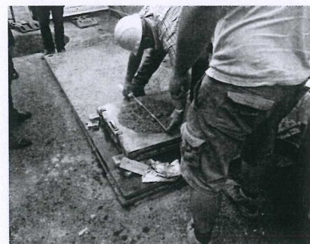
Abb. 2: Überprüfung des Ausbreitmaßes auf der Baustelle
