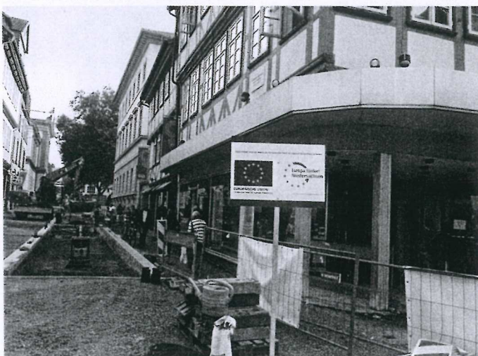
Abb. 4: Blick in die Göttinger Altstadtbebauung
