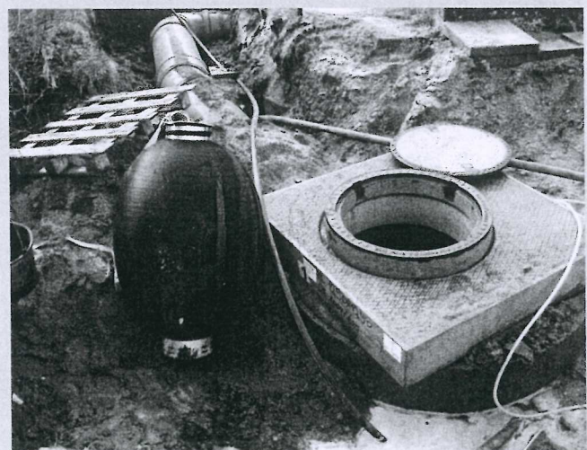
Abb. 1: Absperrblase an der Unfallstelle
