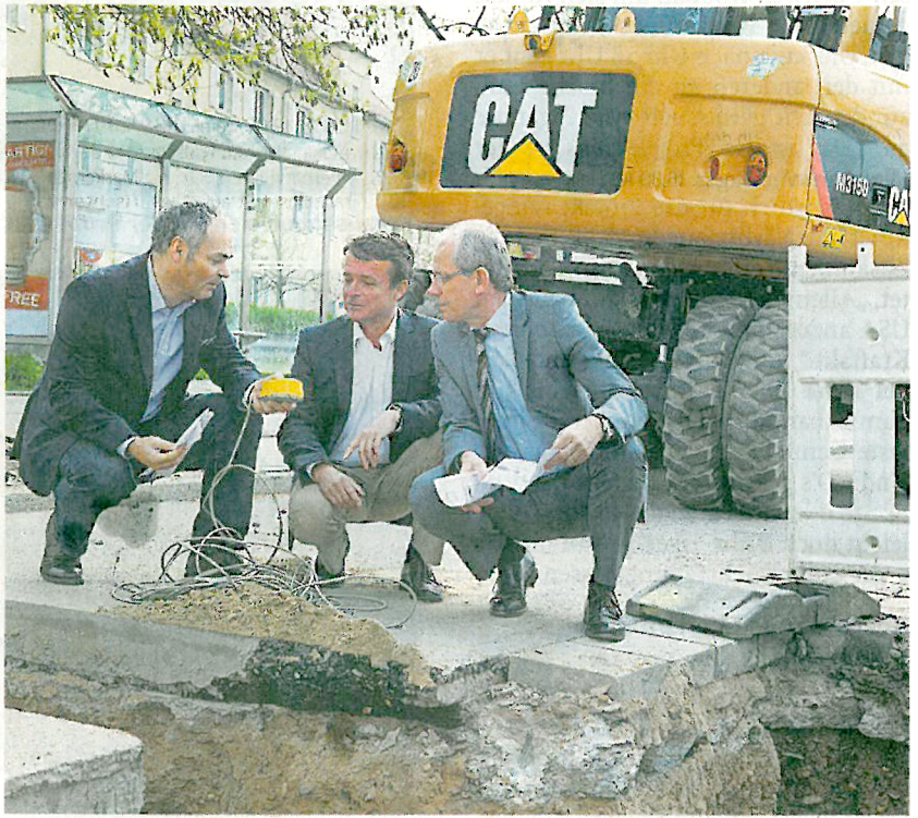
Prof. Dr. Thomas Neidhart, Leiter des Lehrgebiets Geotechnik an der Fakultät für Bauingenieurwesen an der HS.R, Rewag-Bauleiter Fritz Bergmann und Rewag-Vorstandsvorsitzender Norbert Breidenbach (von links) mit Sensor und Bauplänen an der Teststrecke
