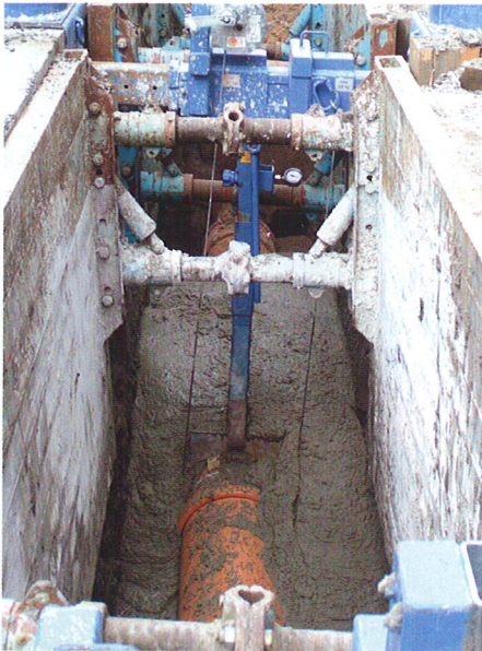
Zu den Einsatzschwerpunkten der Flüssigbodentechnologie gehört unter anderem der Kanalbau.
