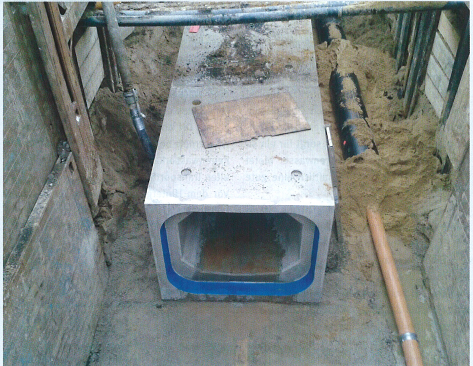
Im Bereich der querenden Gashochdruckleitung wurden Rechteckprofile eingebaut. Rechts der neue Schmutzwasserkanal DN 400 aus PE.
