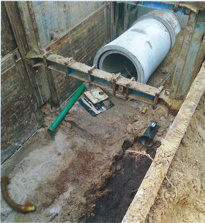
Im ersten Bauabschnitt war es möglich, Regen- und Schmutzwasserkanal in einer Baugrube zu verlegen. Die Verlegetiefe erreichte bis zu 6 Meter.
