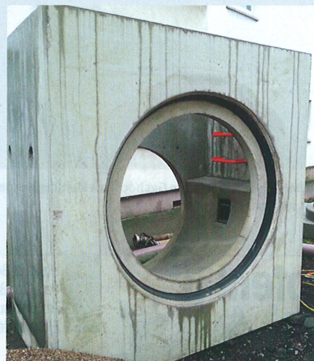
Um den Rohrgraben möglichst schmal zu halten, fiel beim Regenwasserkanal die Wahl auf Rechteckschächte.
