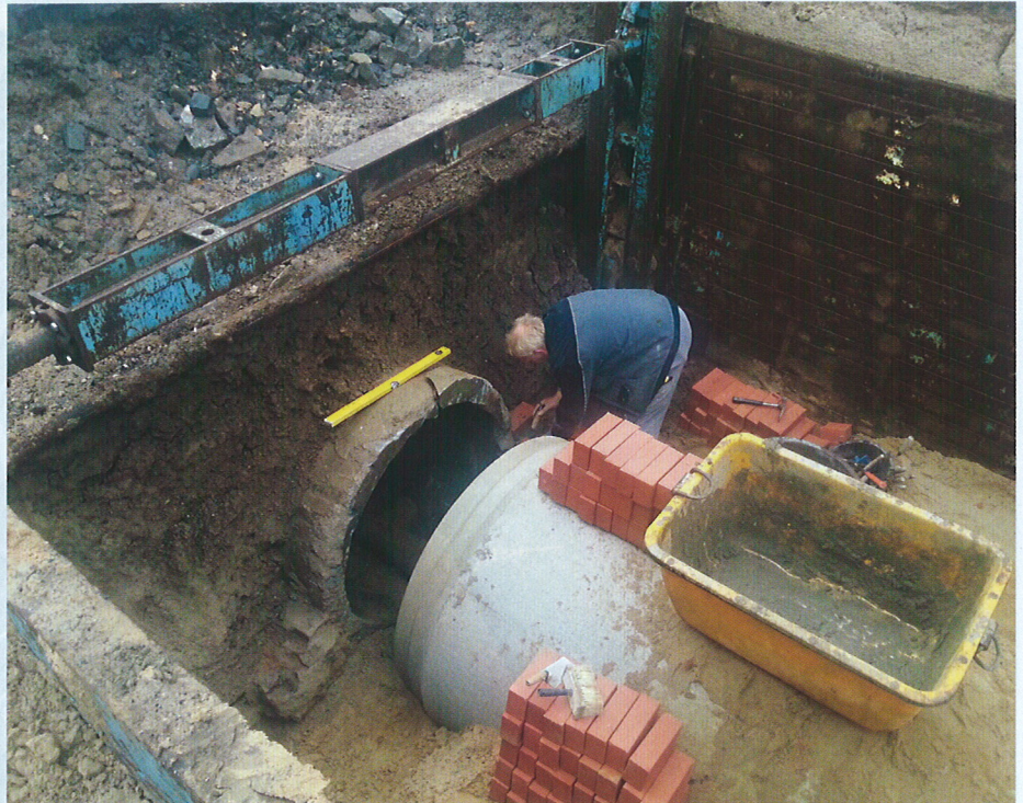
Hier erfolgte eine provisorische Anbindung des neuen an den alten Regenwasserkanal.
