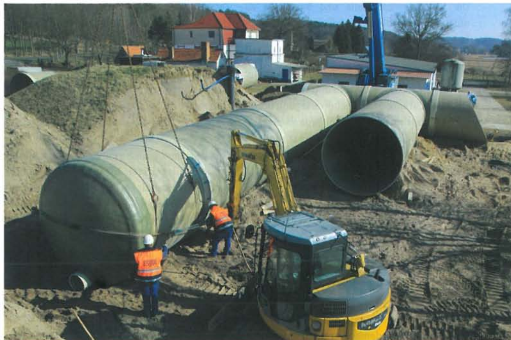
Montage eines Endstücks an einer der Speicherkammern | Foto: Dieter Lindemann, Sassnitz
