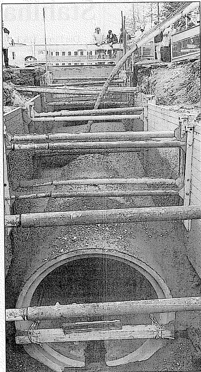
Aus dem Fahrmischer läuft der flüssige Erdboden auf und neben das neue Kanalrohr.
