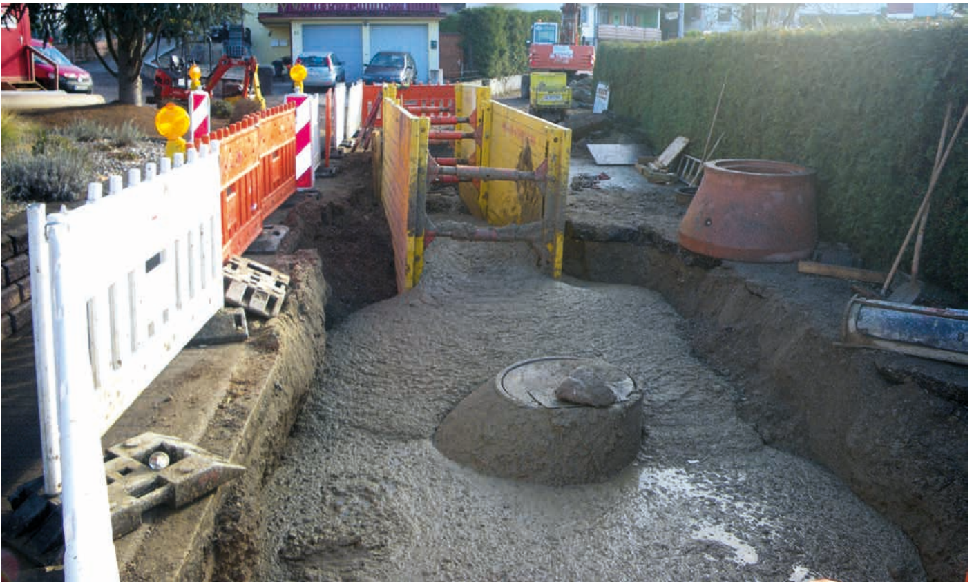
Mit Flüssigboden verfüllte Baugrube bis UK Frostschutzschicht
