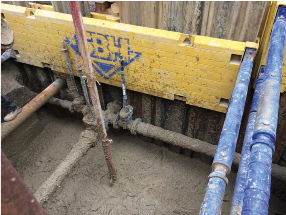
Verfüllung des Rohrgraben für Kanal und Wasserversorgung in der Ratskellerstraße in Achern.
