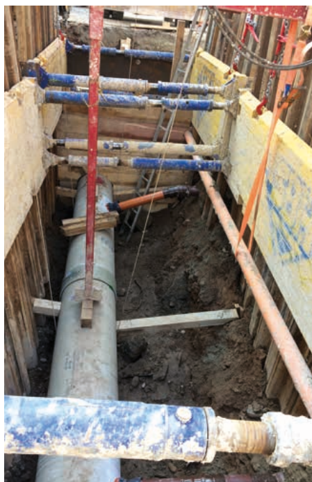
Zur Verfüllung vorbereitete Baugrube mit Auftriebssicherung DN 500 in der Ratskellerstraße Achern.
