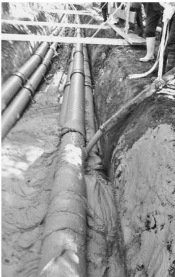
Aus dem Aushub vor Ort wurde thermisch stabilisierender RSS-Flüssigboden TS nach RAL-Gütezeichen 507 hergestellt. Er sorgt für eine optimale Wärmeabfuhr, so dass keine thermische Überlastung des Erdkabels eintritt.
