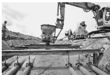
Erdkabel, hier in thermisch stabilisierendem Flüssigboden TS gebettet, können die drei Grundprobleme dieser Verlegetechnik lösen.
