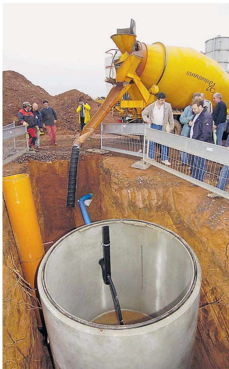
Mit Hilfe einer speziellen Methode wird Bauaushub aufbereitet und mit Zement vermischt, um danach als Füllmasse kostengünstig wieder verwendet zu werden.
