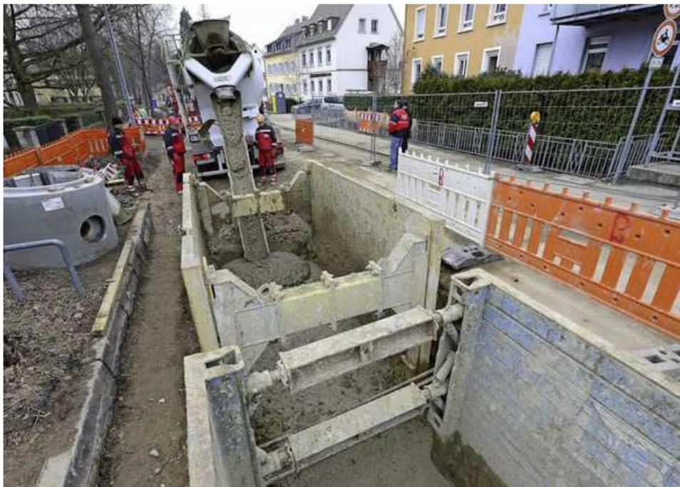
In der Hauptstraße ist der Boden kontaminiert. Aufbereitet und flüssig läuft er über den neuen Kanal. Das Verfahren spart Geld für die Altlast-Entsorgung und zudem den Einsatz von Rüttlern. Foto: Ingo Schneider
