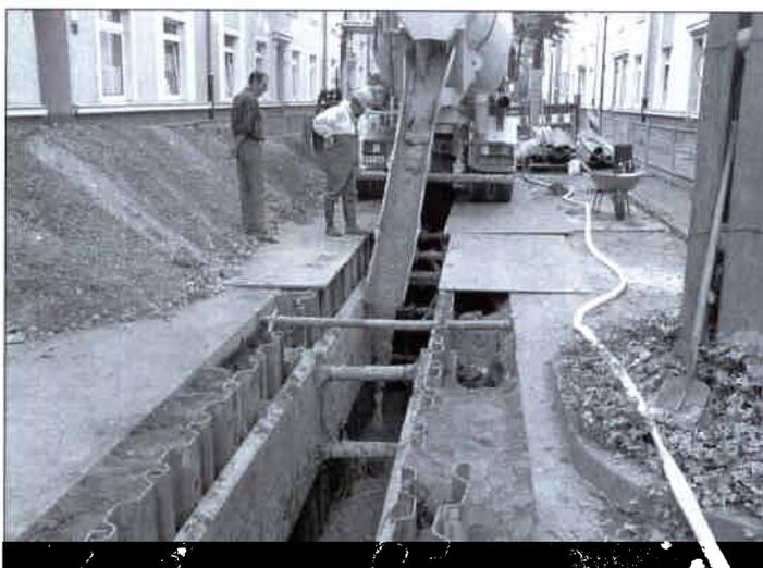
Abbildung 3: Baustelle in Düsseldorf: Einbringen des Flüssigbodens
