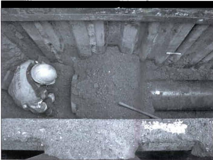
Abbildung 5: Abschottung mit plastischem Material im Bereich der letzten Muffe bis auf Höhe Rohrscheitel
