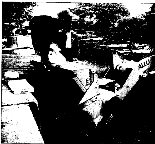
Fot. 2. Wprowadzanie środka wspomagającego – reagentu (tu ze względu na małą objętość gruntu – bezpośrednio do łyżki)
