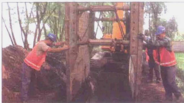
Robotnicy wypełniają wykop zagęszczanym gruntem.
