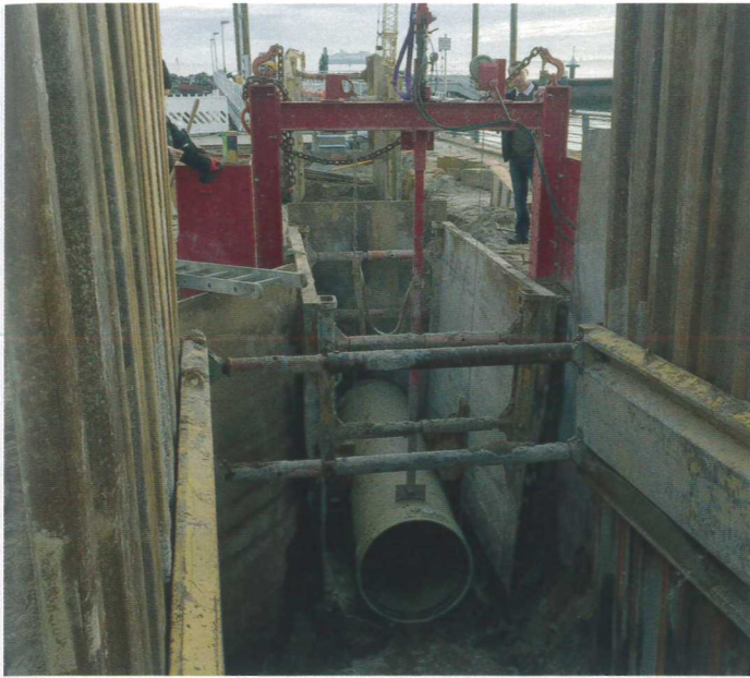
Die Rohre wurden in schwimmender Verlegung in Flüssigböden gebettet.
