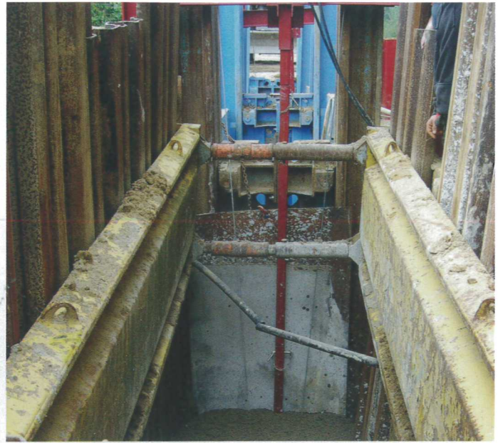
Flüssigboden umschließt die Rohre nahtlos. | Alle Fotos: Tiefbauamt Kiel
