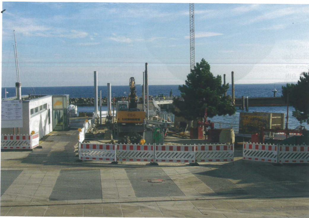
Die Tiefbauarbeiten am Kieler Fähranleger
