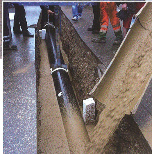
Fernwärmetrasse in Freiburg: Hier kam Flüssigboden nach RAL Gütezeichen 507 zum Einsatz um die Ringspaltbildung zu verhindern. Es wurde in hoher Baufortschritt erreicht – spätere Setzungserscheinungen blieben aus. © RAL GG FB
