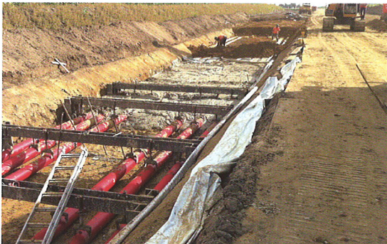
Erdkabeltrasse bei Raesfeld: Hier war eine, landwirtschaftlichen Forderungen berücksichtigende Grabenverfüllung gefordert, wie auch ein optimierter Wärmestrom Q , um das Kabel elektrisch maximal belasten zu können. Dies konnte thermisch stabilisierender Flüssigboden nach RAL Gütezeichen 507 erfüllen. © RAL GG FB
