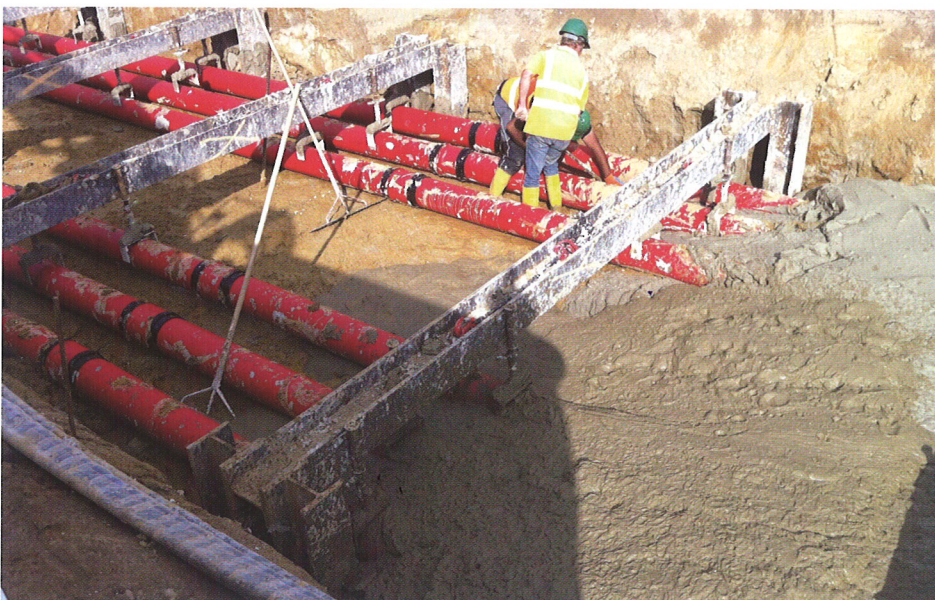
Erdkabeltrasse bei Raesfeld: Hier war eine, landwirtschaftlichen Forderungen berücksichtigende Grabenverfüllung gefordert, wie auch ein optimierter Wärmestrom Q , um das Kabel elektrisch maximal belasten zu können. Dies konnte thermisch stabilisierender Flüssigboden nach RAL Gütezeichen 507 erfüllen. © RAL GG FB
