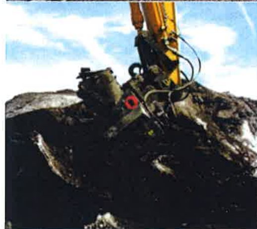
Abbildung 5 Kontaminierte Böden in Luxemburg (DK 3), Esch Belval- Tunnelbau (IB LOGIC)
