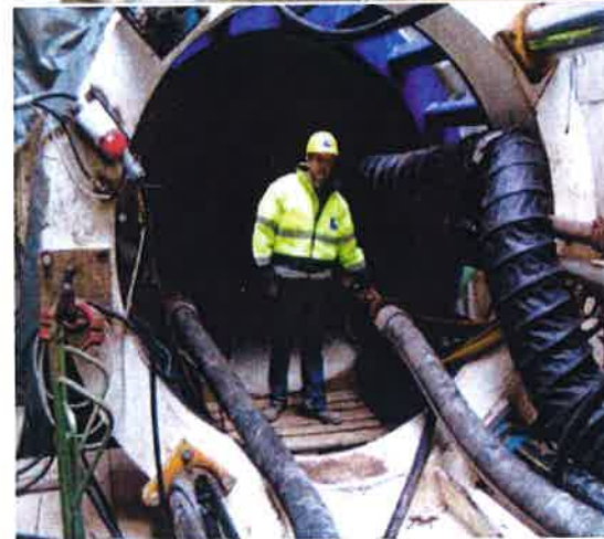
Abbildung 3 RSS Flüssigboden bei der hohlraumfreien Verfüllung historischer Keller und bei Vortriebsbohrungen (FiFB)
