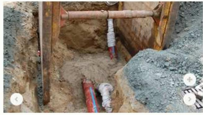
Nachdem die Hausanschlüsse erneuert sind, werden die Rohre fixiert. Dann kommt der Flüssigboden in den Schacht und der Verbaukasten wird gezogen.
