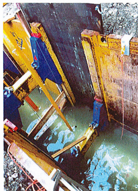
Schwimmende Verlegung im und unter Wasser ohne Wasserhaltung
