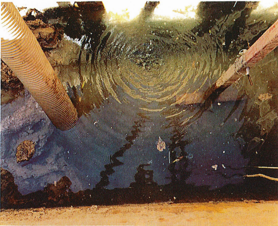
Schwimmende Verlegung mit einer Bodenplatte aus RSS-Flüssigboden als zusätzliche Auflast
