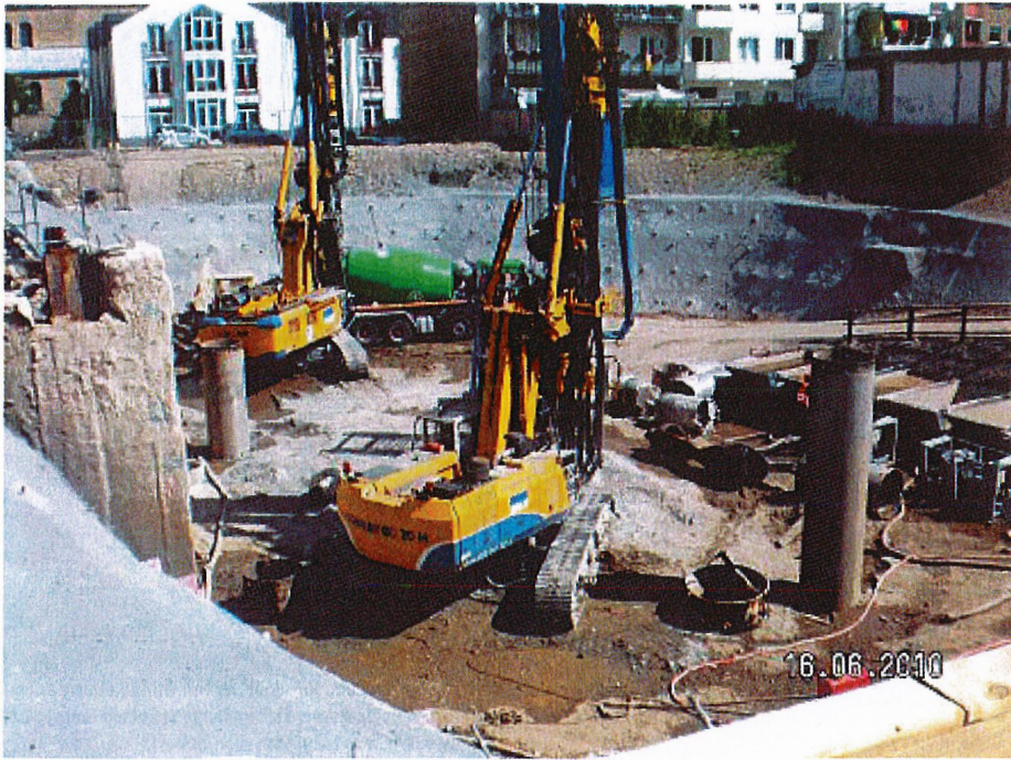
Sanierung der Einsturzstelle mit überschneidenden Bohrpfählen aus RSS-Flüssigboden | Foto: Ingenieurbüro Logic
